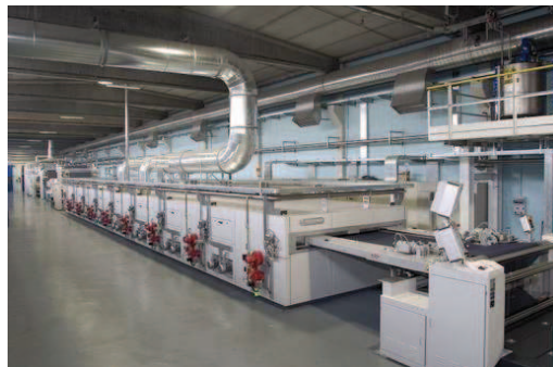
Figura 18. Rame de termofijado de tejido. Fuente: material formativo propio
