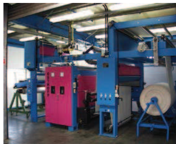
Figura 13. Instalación de chamuscado de tejidos. Fuente: material formativo propio
